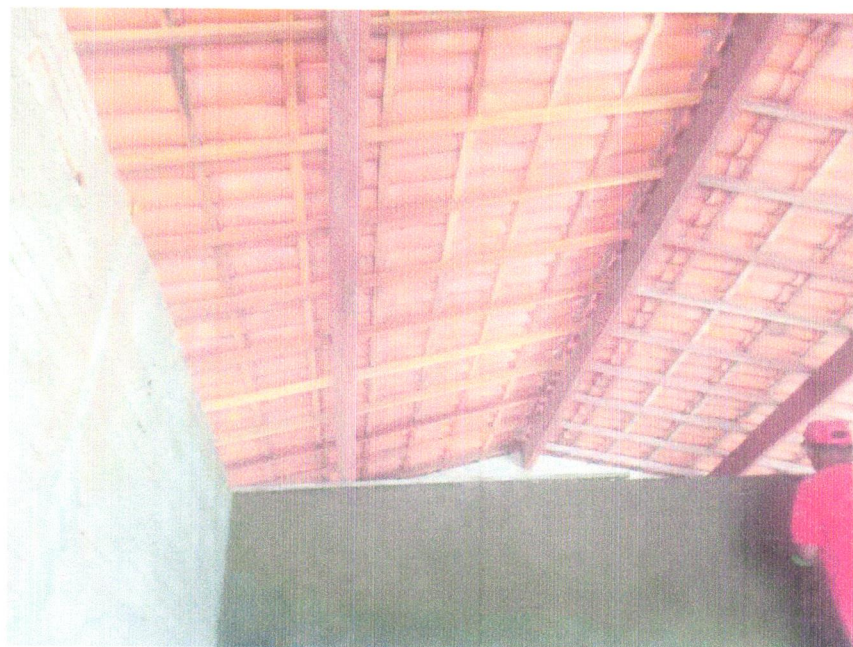
FOTO 08 - Retelhameto em cobertura com telha ceramica tipo canal comum, Itabaiana ou similar.
