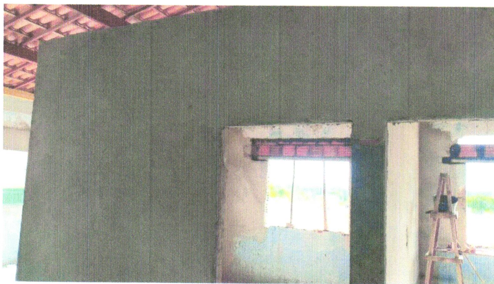
FOTO 05 – MASSA ÚNICA, PARA RECEBIMENTO DE PINTURA OU CERÂMICA, ARGAMASSA INDUSTRIALIZADA, PREPARO MECÂNICO, APLICADO COM EQUIPAMENTO DE MISTURA E PROJEÇÃO DE 1,5 M 3 /H EM FACES INTERNAS DE PAREDES, ESPESSURA DE 5MM, SEM EXECUÇÃO DE TALISCAS. AF_06/2014
