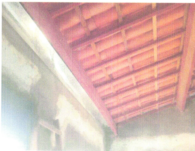
FOTO 03 - TELHAMENTO COM TELHA CERÂMICA CAPA-CANAL, TIPO COLONIAL, COM ATÉ 2 ÁGUAS, INCLUSO TRANSPORTE VERTICAL. AF_07/2019
