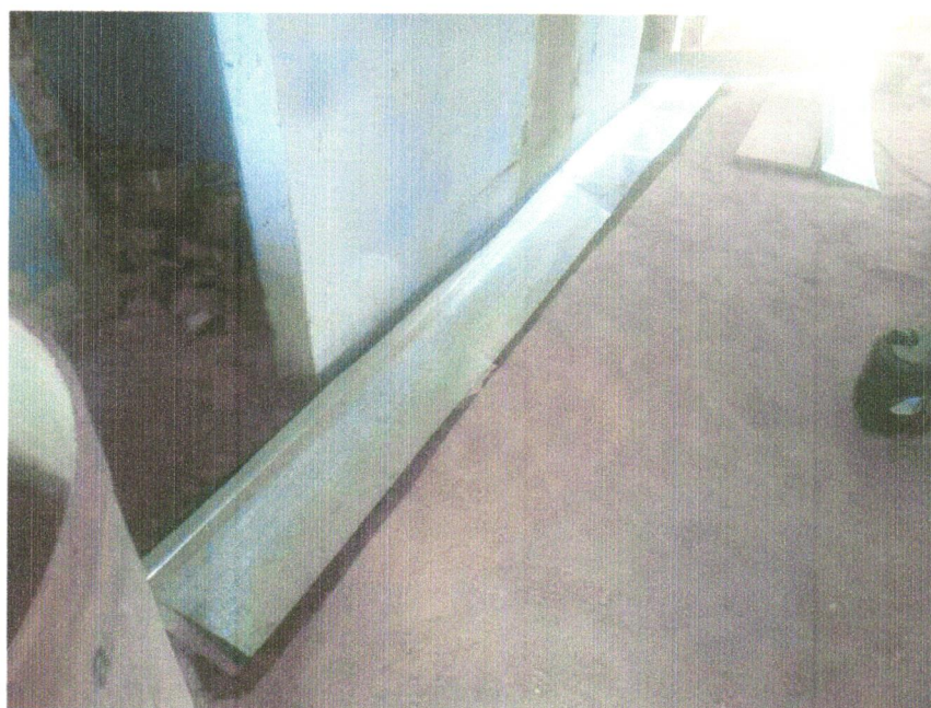
FOTO 02 – Rufo em chapa aço galvanizado nº24 com desenvolvimento 25cm
